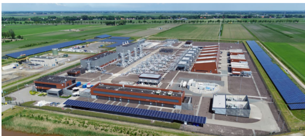
1 De huidige aardgasopslag in Zuidwending
