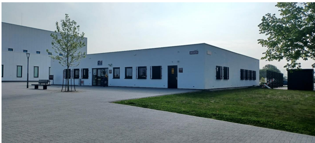
Figuur 3: Een van de stenen gebouwen zonder geschikte verblijfplaatsen voor de gierzwaluw.
