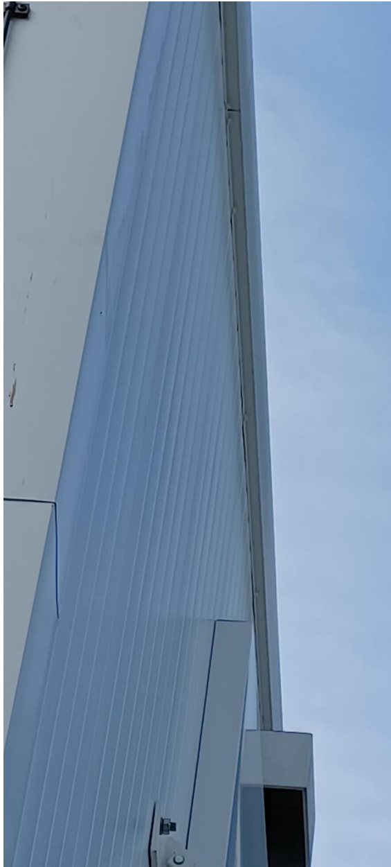
Figuur 4: De gebouwen en loodsen zijn tot aan het dak afgewerkt en vertonen geen geschikte openingen voor de gierwaluw.
