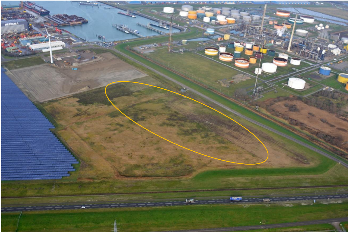
Figuur 2-2 Dronebeeld (in noordelijke richting) van het terrein aan de Belgiëweg Oost in Borssele met in oranje cirkel globale aanduiding locatie converterstation
