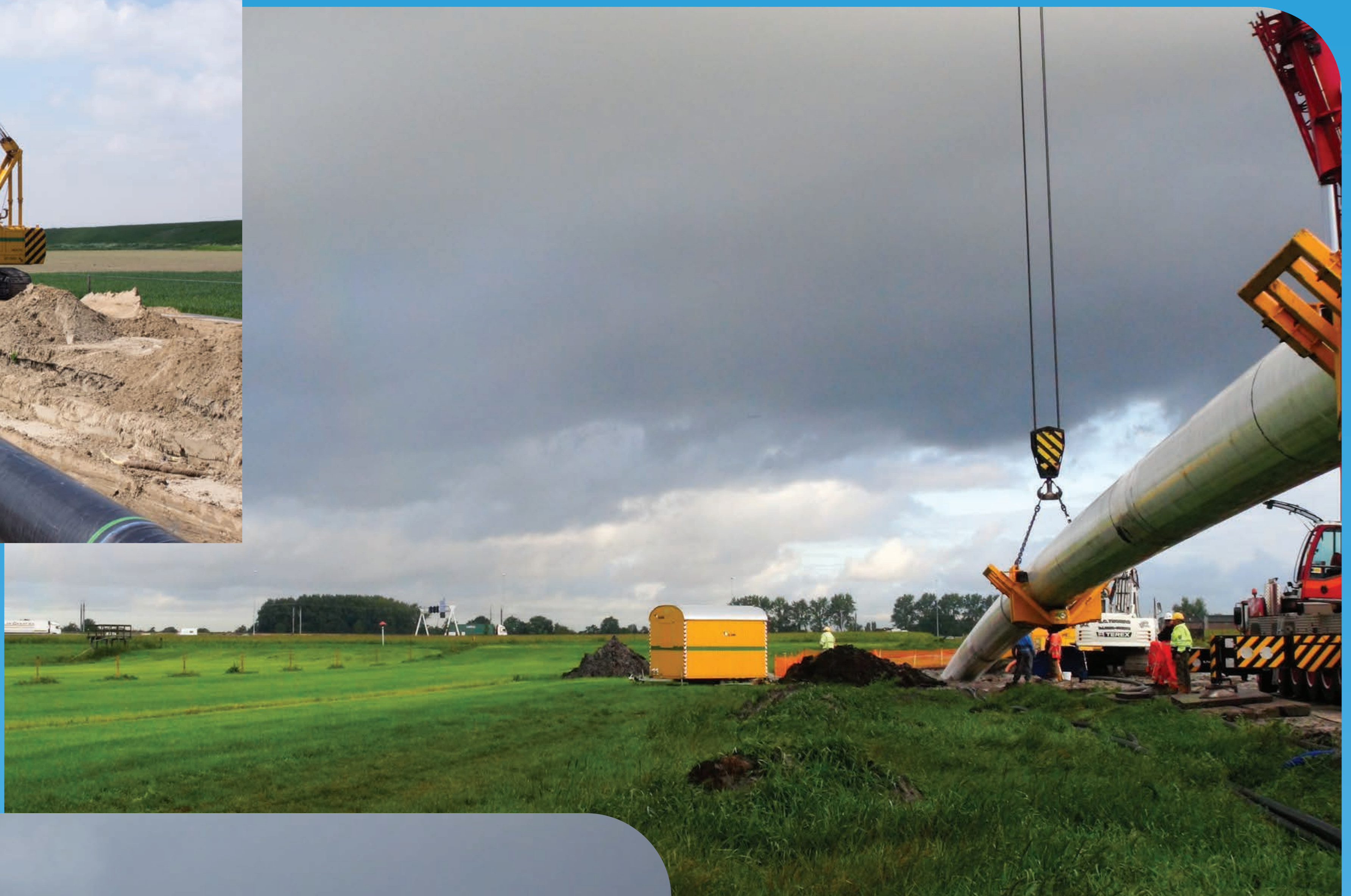
Aanleg leiding met horizontaal gestuurde boring
