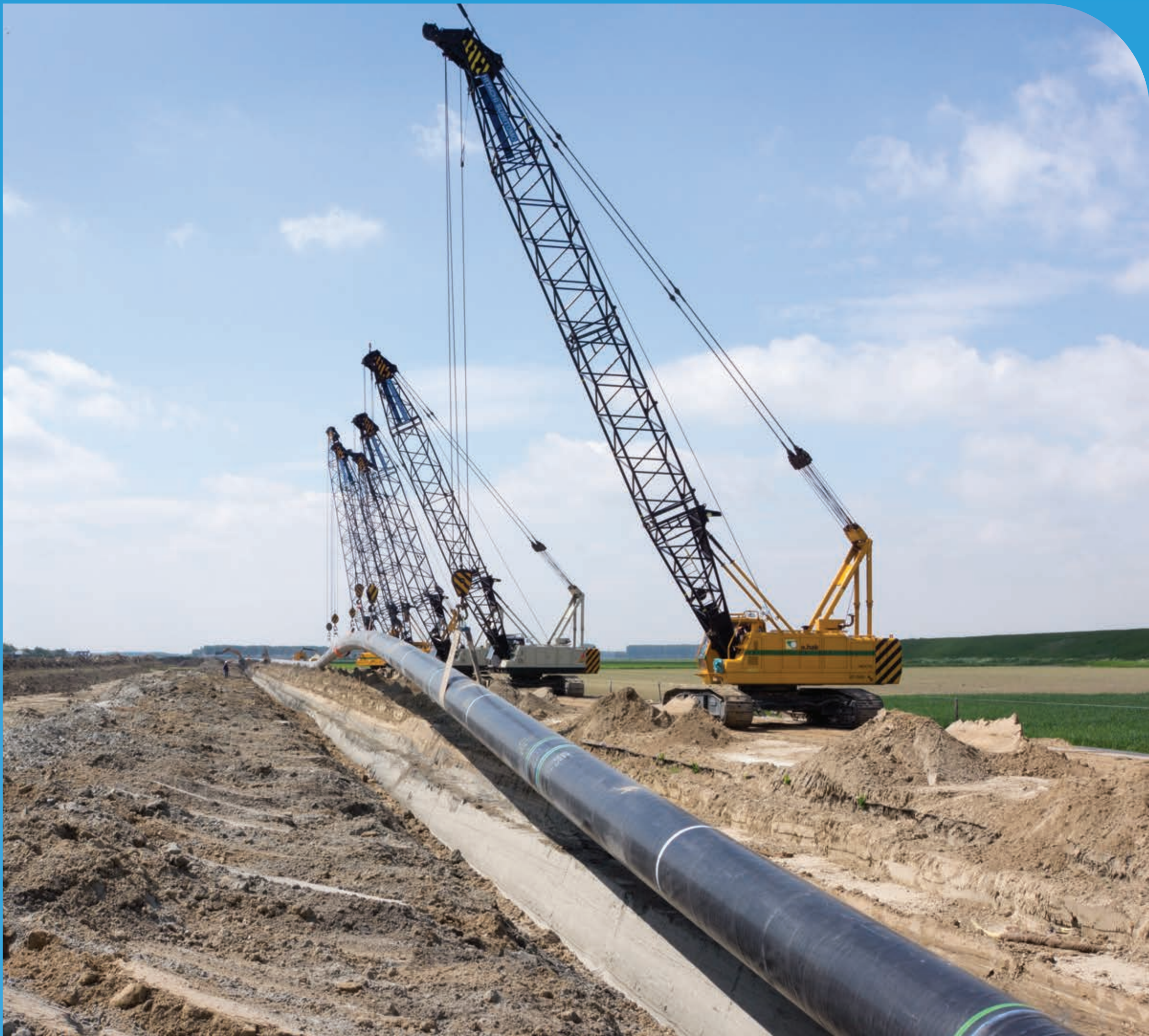
Aanleg leiding met open ontgraving
