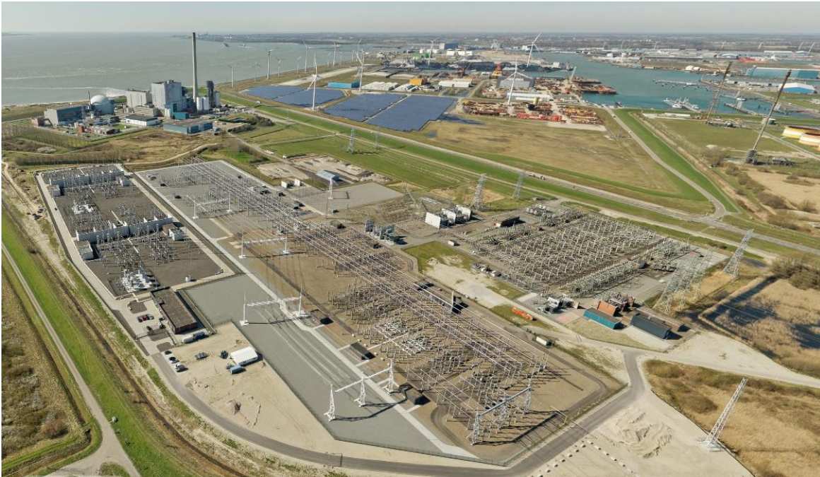
Figuur 6 Huidige situatie van het 380kV-station Borssele.
