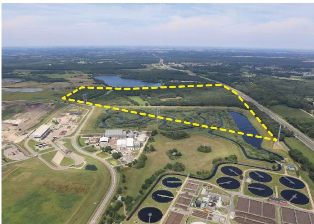
Figuur 6: luchtfoto hoogspanningsstation locatie de Spinder
