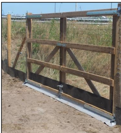
Figuur 6. Voorbeeld van een hek met flappen zodat amfibieën niet het terrein binnen gaan (bron: De Haas afrasteringen).
