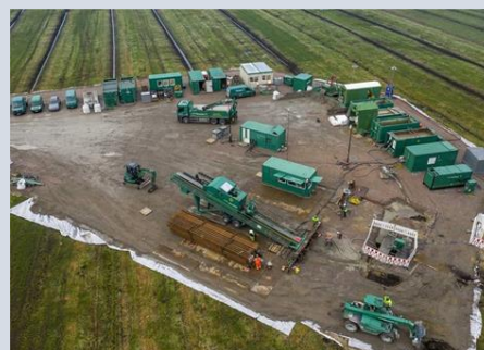
Abbildung 4-8: Beispiel Baustelle (HDD-Verfahren) an Land
