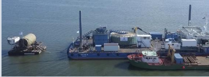
Abbildung 4-9: Beispiel Transport von Kabeln zur Baustelle im Watt
