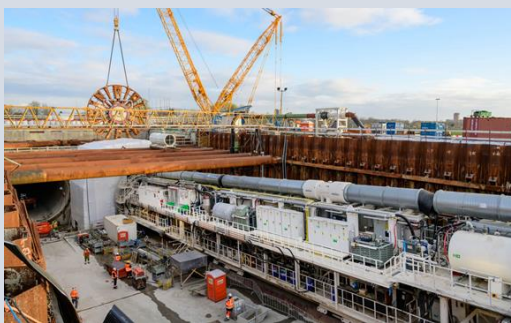
Afbeelding 4-7: Voorbeeld van een geboorde tunnel
