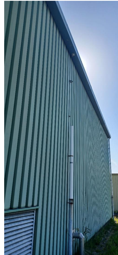
Figuur 1: Een van de metalen loodsen binnen het plangebied. De metalen loodsen zijn tot aan het dak afgewerkt en bevatten een enkele ijzeren plaat als zijwand. Er zijn geen geschikte holtes voor de gierwaluw aangetroffen.
