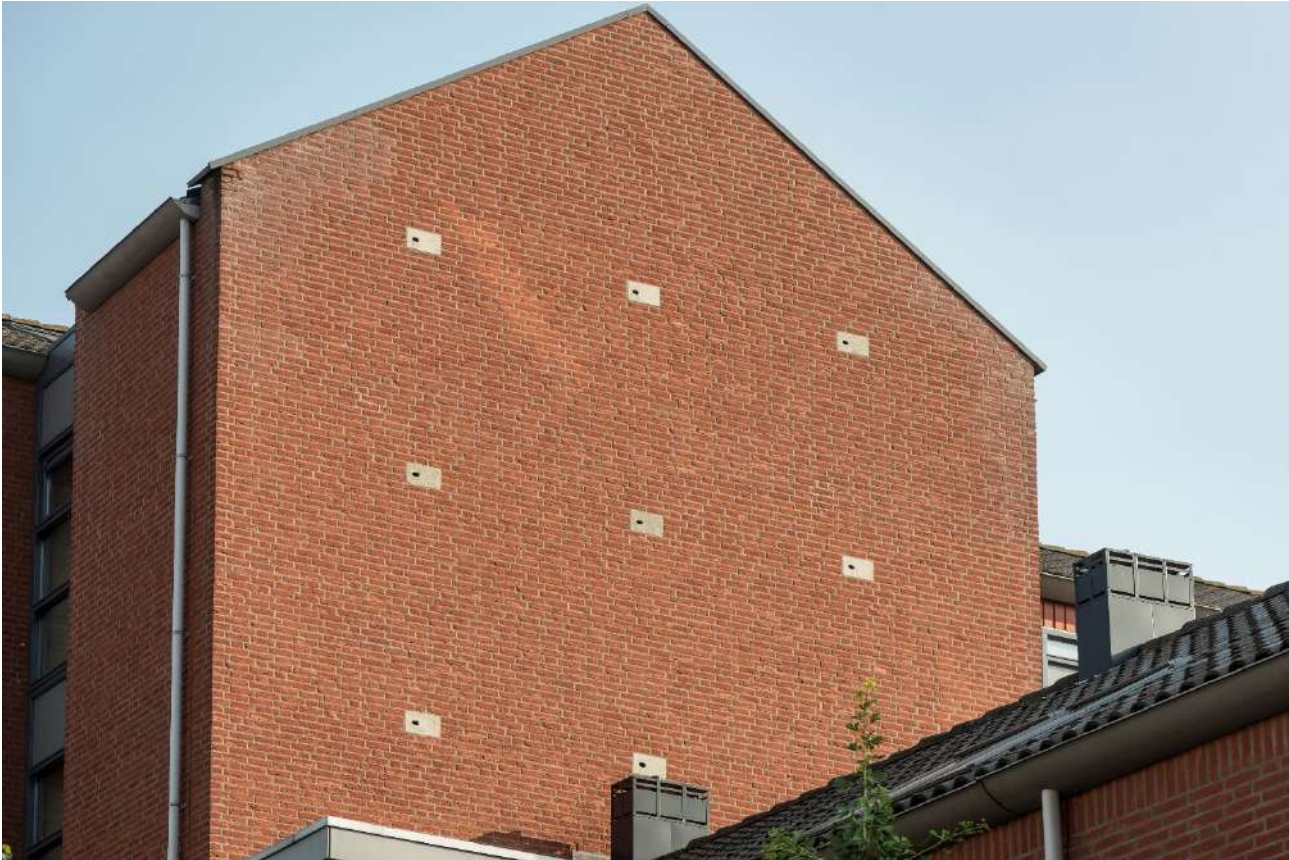
Gierzwaluwkasten ingebouwd in de kopgevel van een appartementencomplex (Bron: Vivara Pro)
