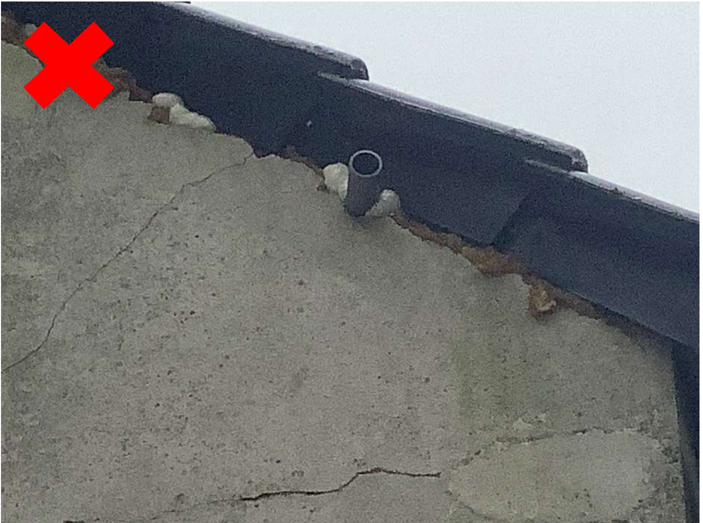
Figuur 5 Foutieve 'exclusion flap' (het pijpje)
