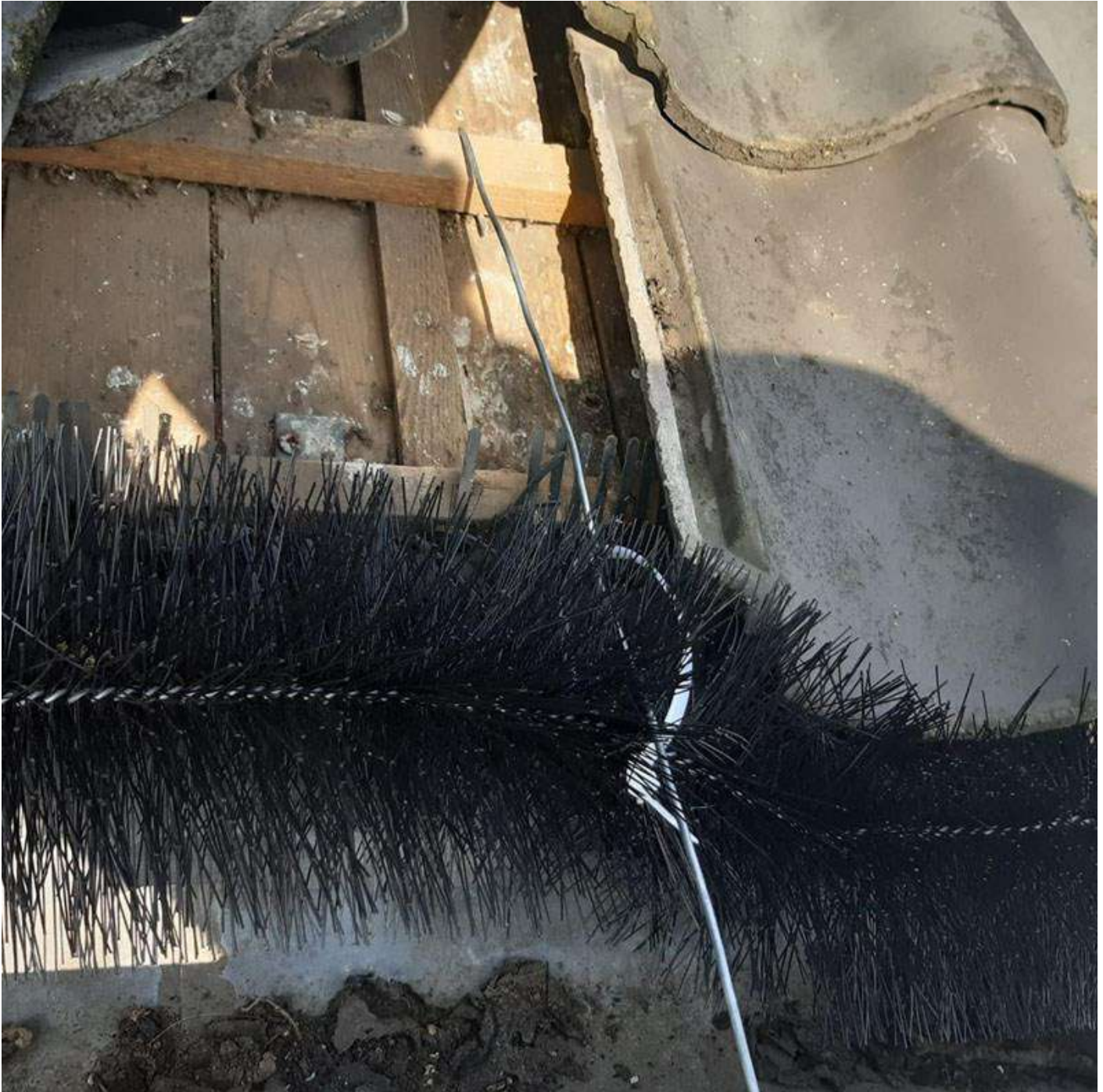
Figuur 7 Spouwborstel vastgezet met borstelhaak (Bron: Unitura.nl)
