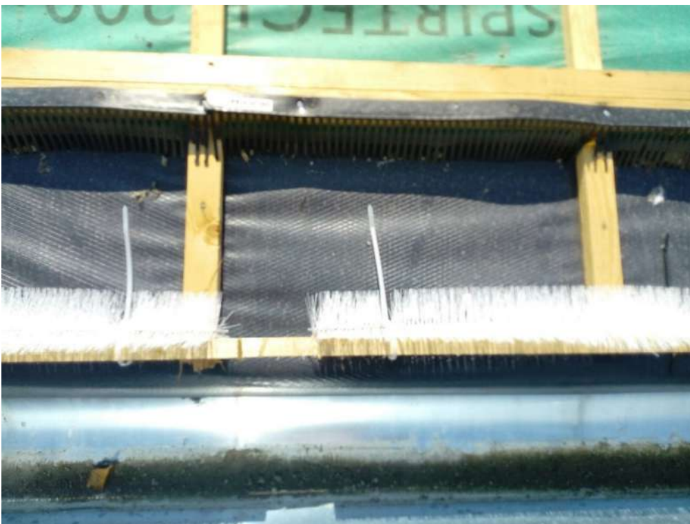
Voorbeeld afgezet verblijf onder dakrand. De bodem is afgedekt met ruw materiaal en het verblijf is rondom afgesloten met houten panlatten i.c.m. vogelschroot of spouwborstels. Door een opening van 35 mm te houden kan de huismus het verblijf bereiken (Bron: Arcadis)
