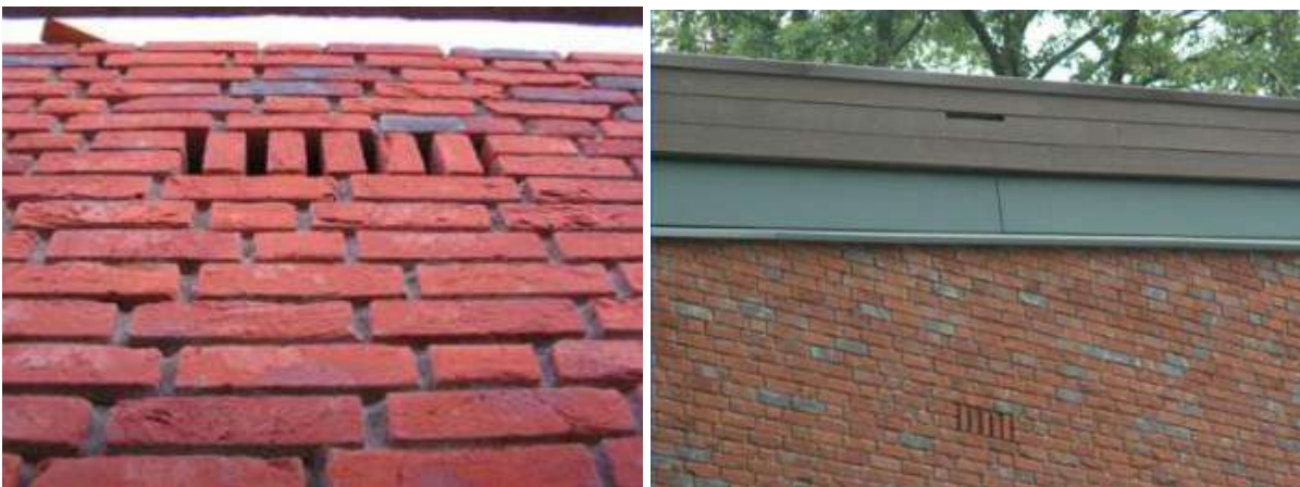
Uitvoeringsvoorbeeld openingen spouwmuur met open stootvoegen. Deze zijn door de breedte (minimaal 25 mm) geschikt voor zowel grotere soorten (o.a. meervleermuis, laatvlieger) als kleinere soorten (onder andere gewone dwergvleermuis, ruige dwergvleermuis gewone grootoorvleermuis) (Bron: vleermuizenindestad.nl)
