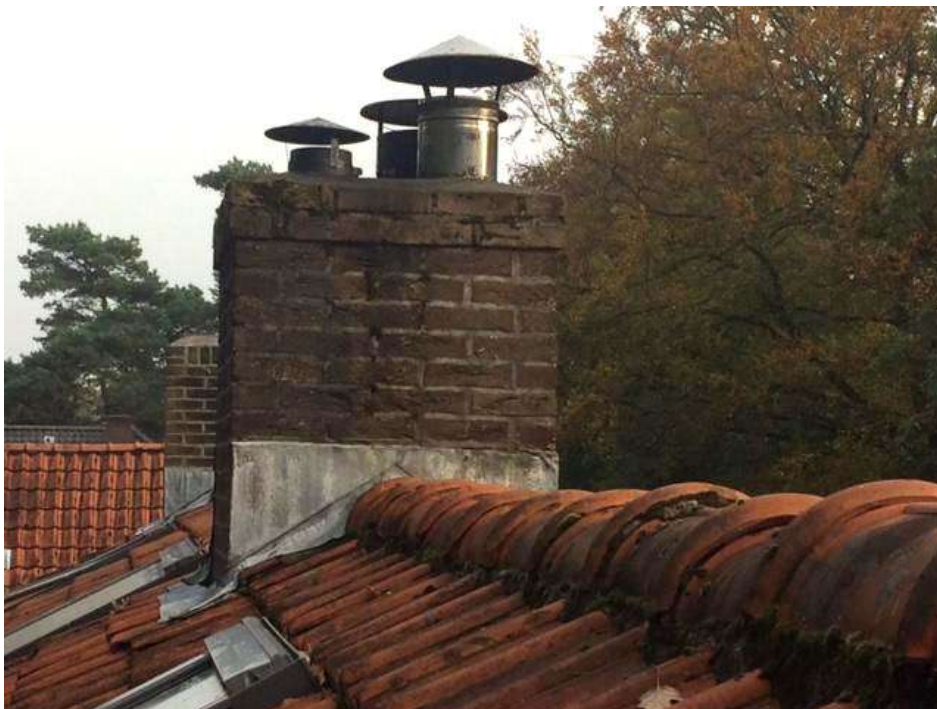
Voorbeeld schoorsteen met loodslab (Bron: Werkspot.nl)
