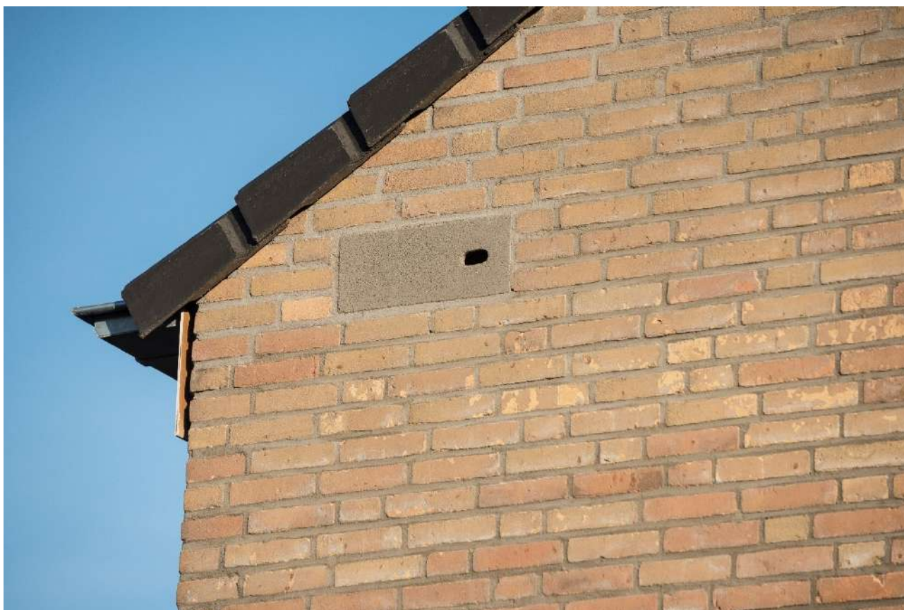
Inbouwkast van gierzwaluw verwerkt in de kopgevel van een woning (Bron: Vivara Pro)
