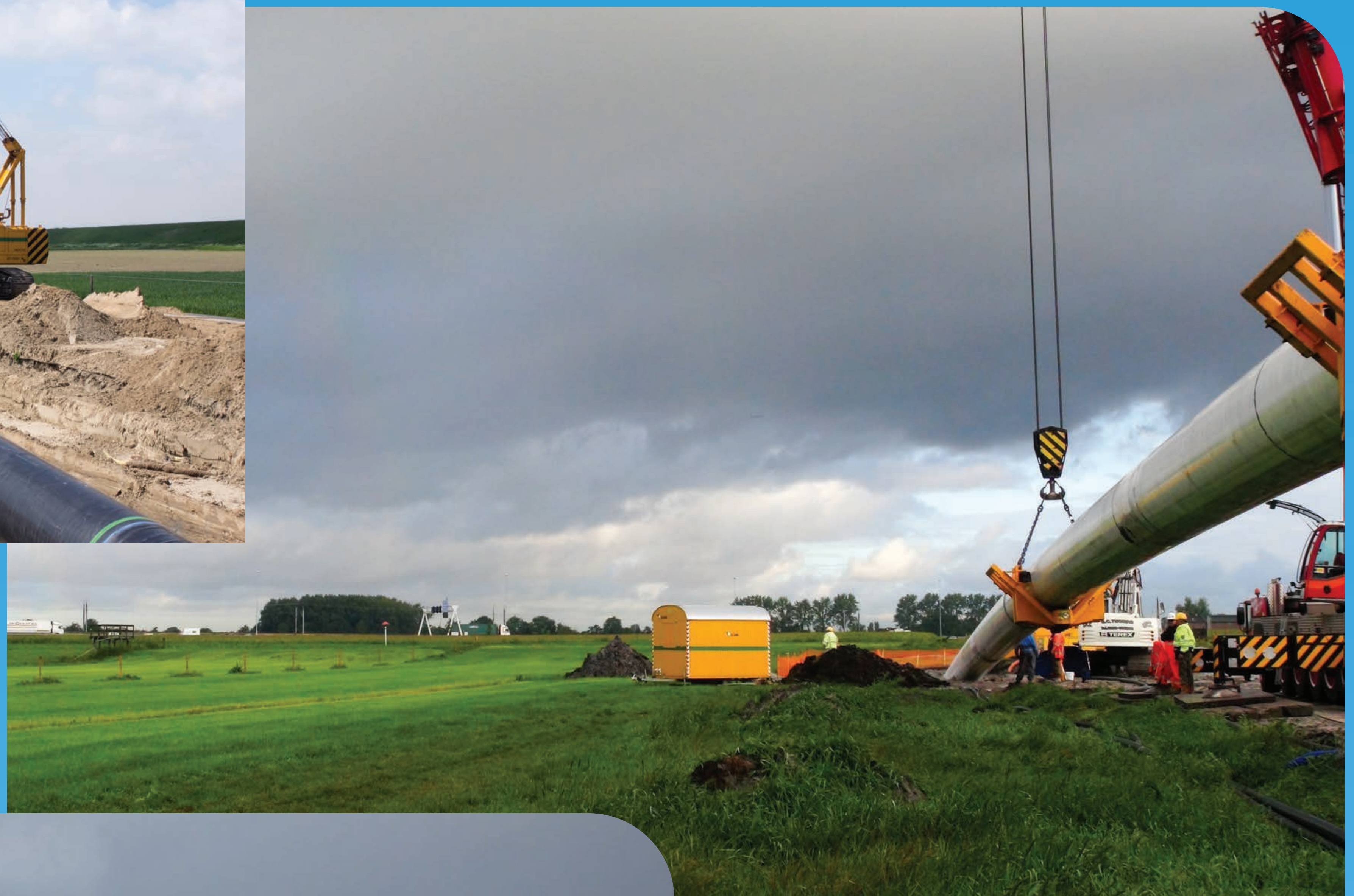
Aanleg leiding met horizontaal gestuurde boring
