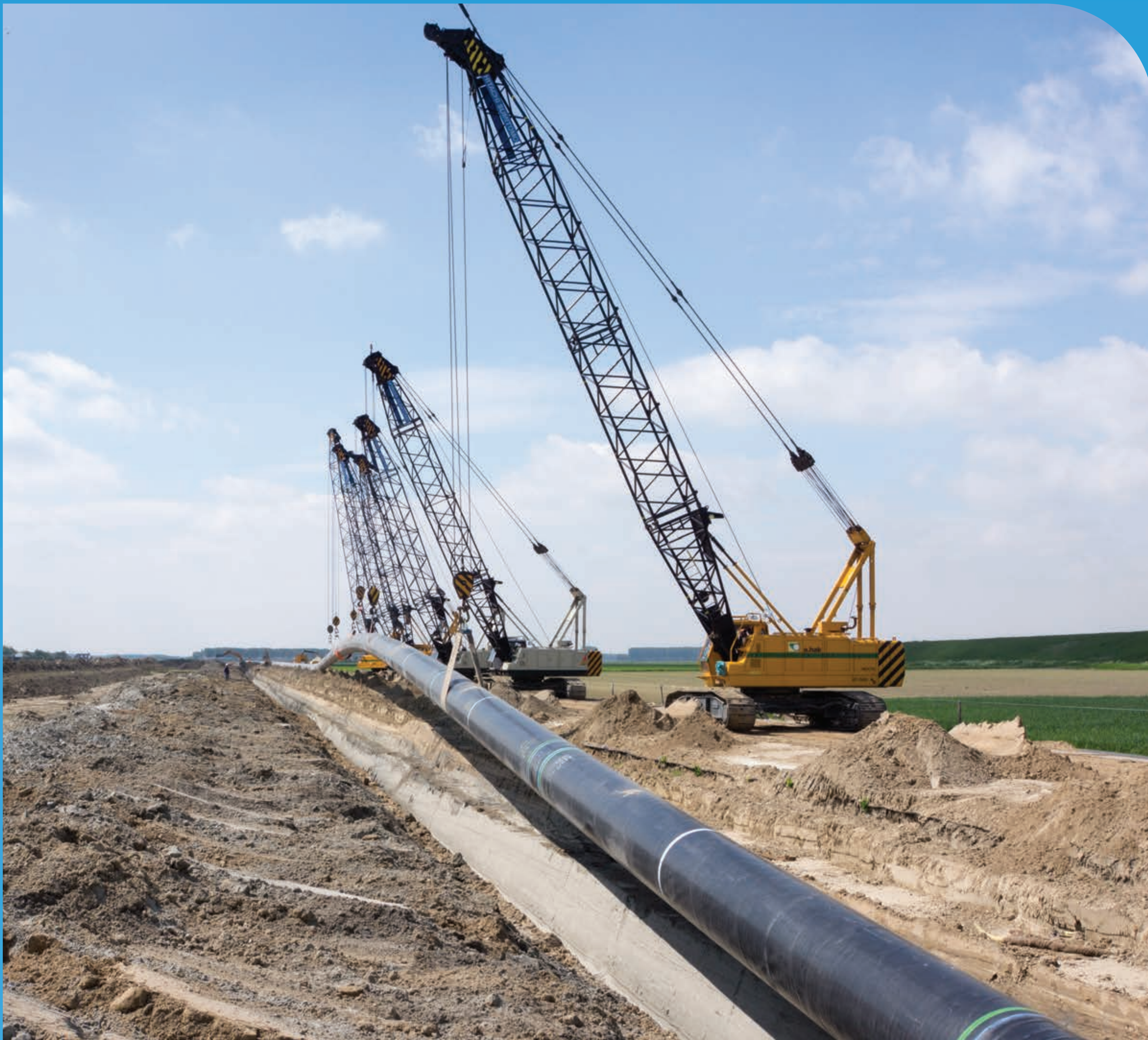
Aanleg leiding met open ontgraving
