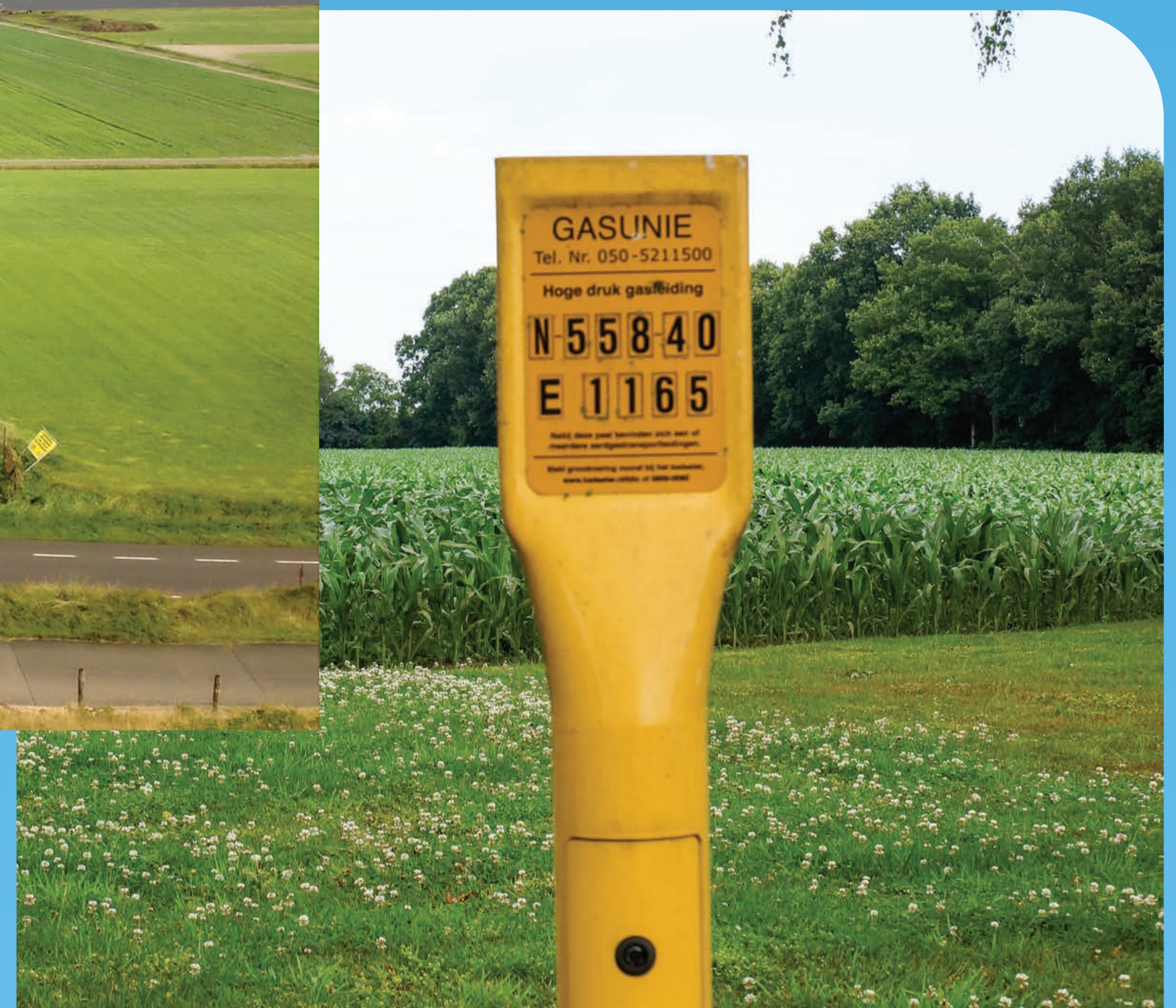
Gasunie-paaltje in landschap na aanleg leiding
