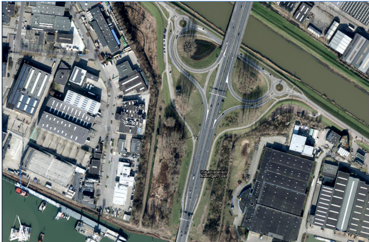
Figuur 1: Het plangebied ligt aan weerszijden van de afrit Avelingen van de rijksweg A27 nabij Gorinchem.
