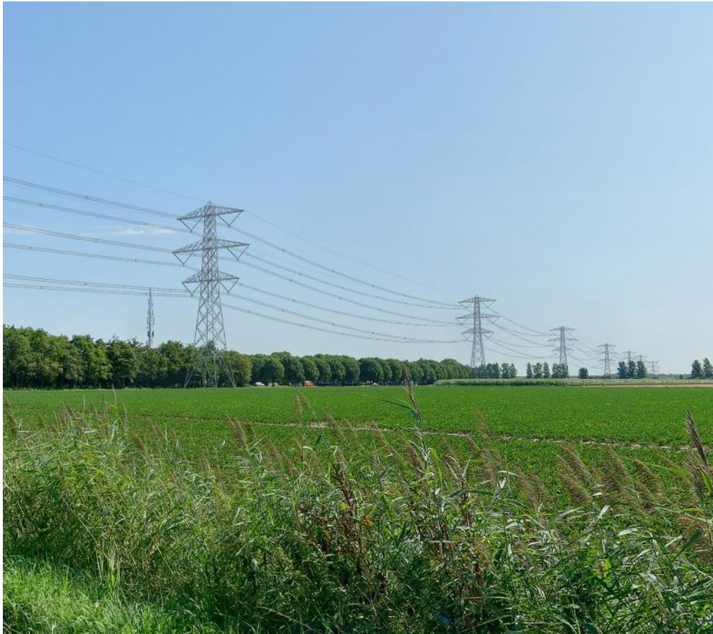
Afbeelding 4: 3D-Visualisatie van een 2-circuits 380kV-hoogspanningsverbinding
