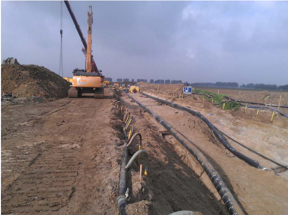
Afbeelding 3. Aanleg gasleiding in open ontgraving
