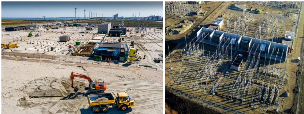
Afbeelding 34. Foto's van werkzaamheden aanleg transformatorstation
