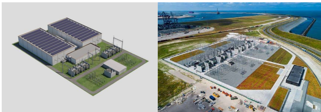
Afbeelding 3.6 Convertorstation (links) en transformatorstation (rechts).
