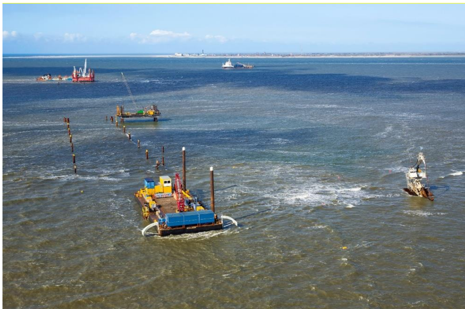
Afbeelding 22. Uitvoering van een HDD onder de NGT-leiding (met moflocatie, baggerwerkzaamheden en kabelinstallatie met wadtrencher)
