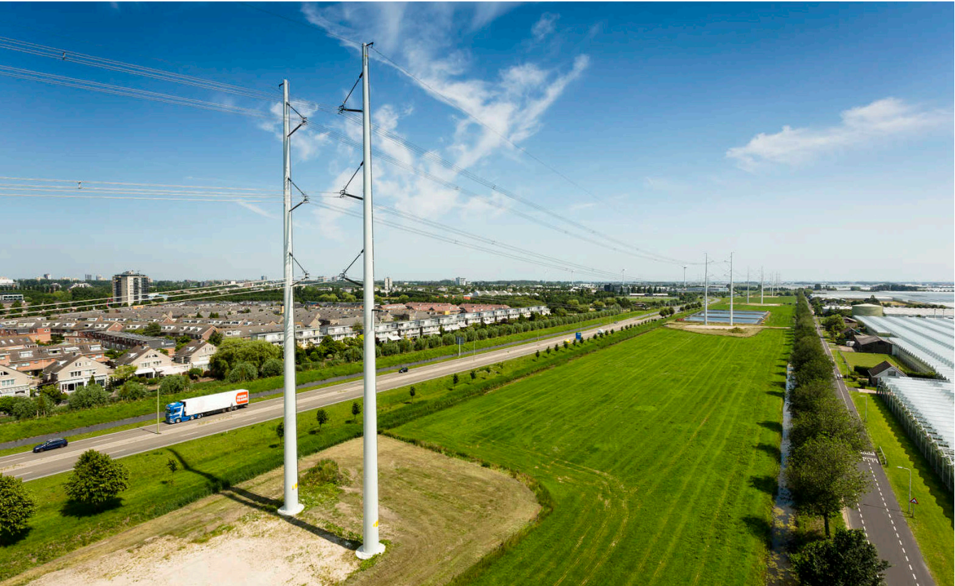
De Wintrackmasten hebben een modernere uitstraling dan de traditionele vakwerkmast en hebben ze de eigenschap het landschap te doorsnijden Bron: https://www.zja.nl/Wintrack-masten
