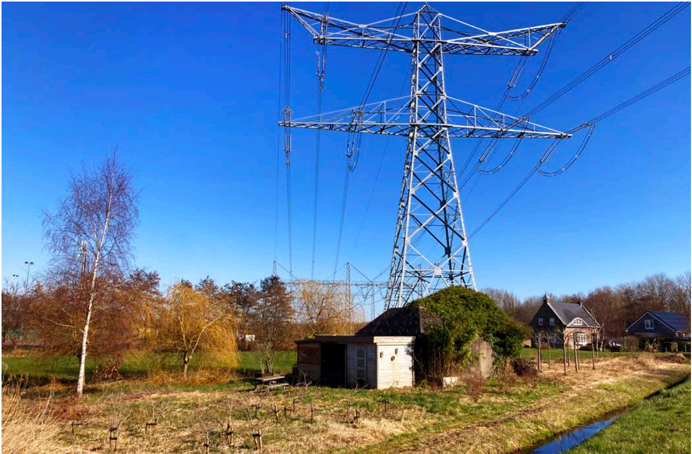
Tijdens een veldbezoek aan het werelderfgoed van de Hollandse Waterlinies werd duidelijk hoe hoogspanningslijnen en erfgoed soms dicht bij elkaar komen
