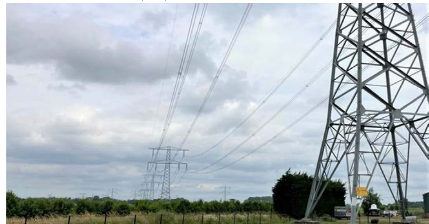
Afbeelding 1.1 Foto van een 380 kV-hoogspanningsverbinding
