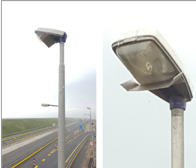
Figuur 4.10 Om tijdens wegwerkzaamheden verstrooiing van licht naar de omgeving te voorkomen zijn de tijdelijke straatlantaarns voorzien van kapjes, zodat het licht alleen de weg verlicht en niet de dijk of het IJsselmeer (Foto's: [REDACTED] / Waardenburg Ecology).
