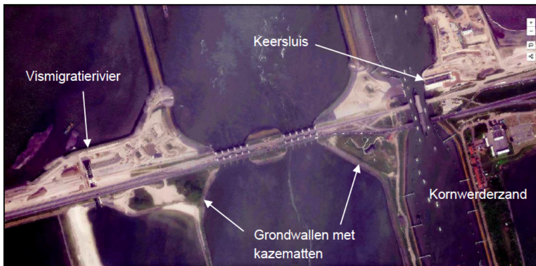
Figuur 4.12 De situatie van spuicomplex keersluis Kornwerderzand in apr/mei 2023 (bron: www.satellietdataportaal.nl ).
