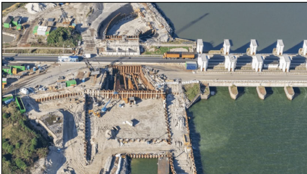
Figuur 2.4 Werkzaamheden voor de aanleg van pompgemaal 1 (foto: [redacted] / Rijkswaterstaat).
