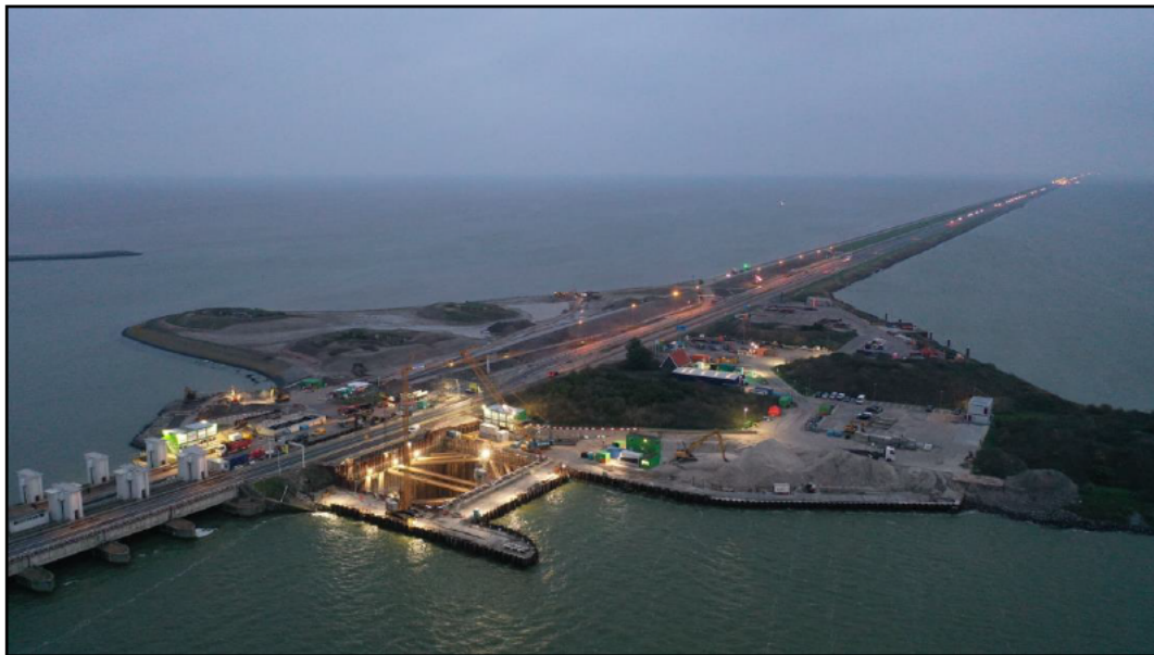
Figuur 4.9 Werkzaamheden aan een van de pompgroepen in het spuicomplex Den Oever. Duidelijk is te zien dat het kunstlicht alleen de werkplekken verlicht en niet de omgeving (Foto: [REDACTED]/Rijkswaterstaat).
