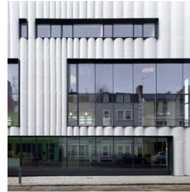
Afb. 18 Gewalste aluminium plaat
