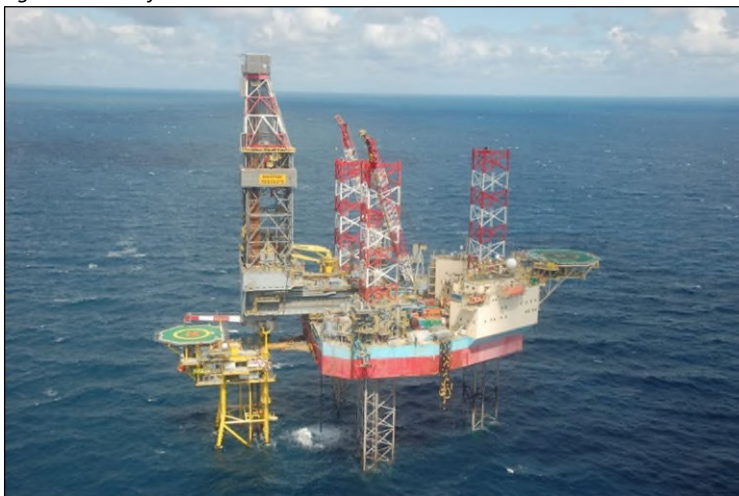
Figuur 1.2: Boorinstallatie (rechts) tijdens eerdere boring bij platform A18 (links), deels vergelijkbaar met platform A12 CPP
