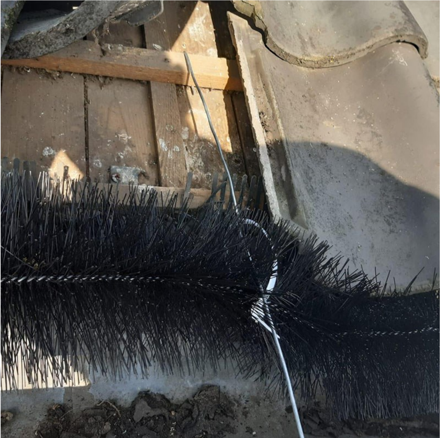
Figuur 7 Spouwborstel vastgezet met borstelhaak (Bron: Unitura.nl)
