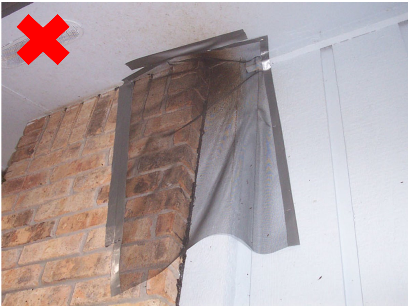
Figuur 4 Foutieve toepassing van exclusion flaps
