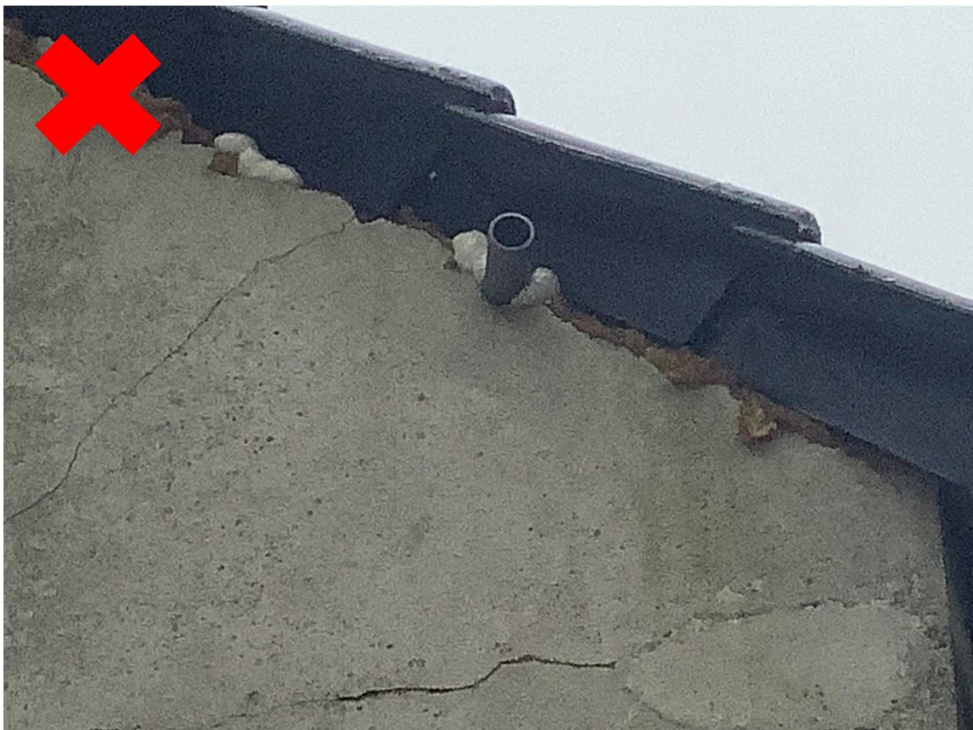
Figuur 5 Foutieve 'exclusion flap' (het pijpje)
