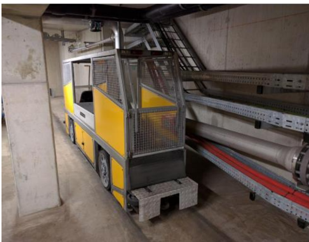
Figuur 20 Foto van ruimte onder tunneldek Westerschelde, andere infrastructuur en onderhoudsvoertuig /3/.
