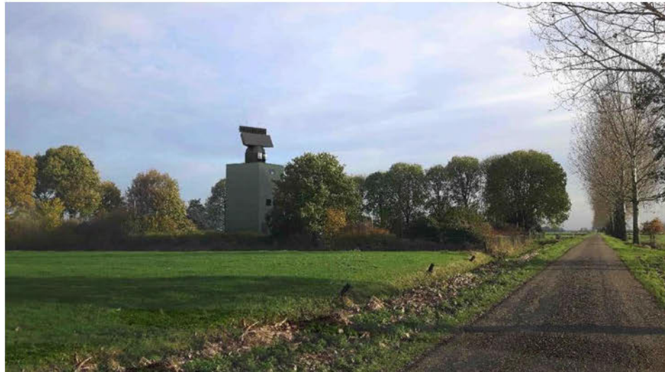
Figuur 2 Impressie van de SMART-L radar aan de Broekgraaf 1 te Herwijnen (Bron: Thales, gebruikt met toestemming).
