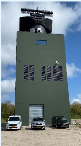
figuur 3: foto van zuidgevel van radarantenne
