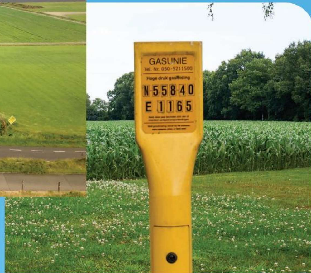
Gasunie-paaltje in landschap na aanleg leiding
