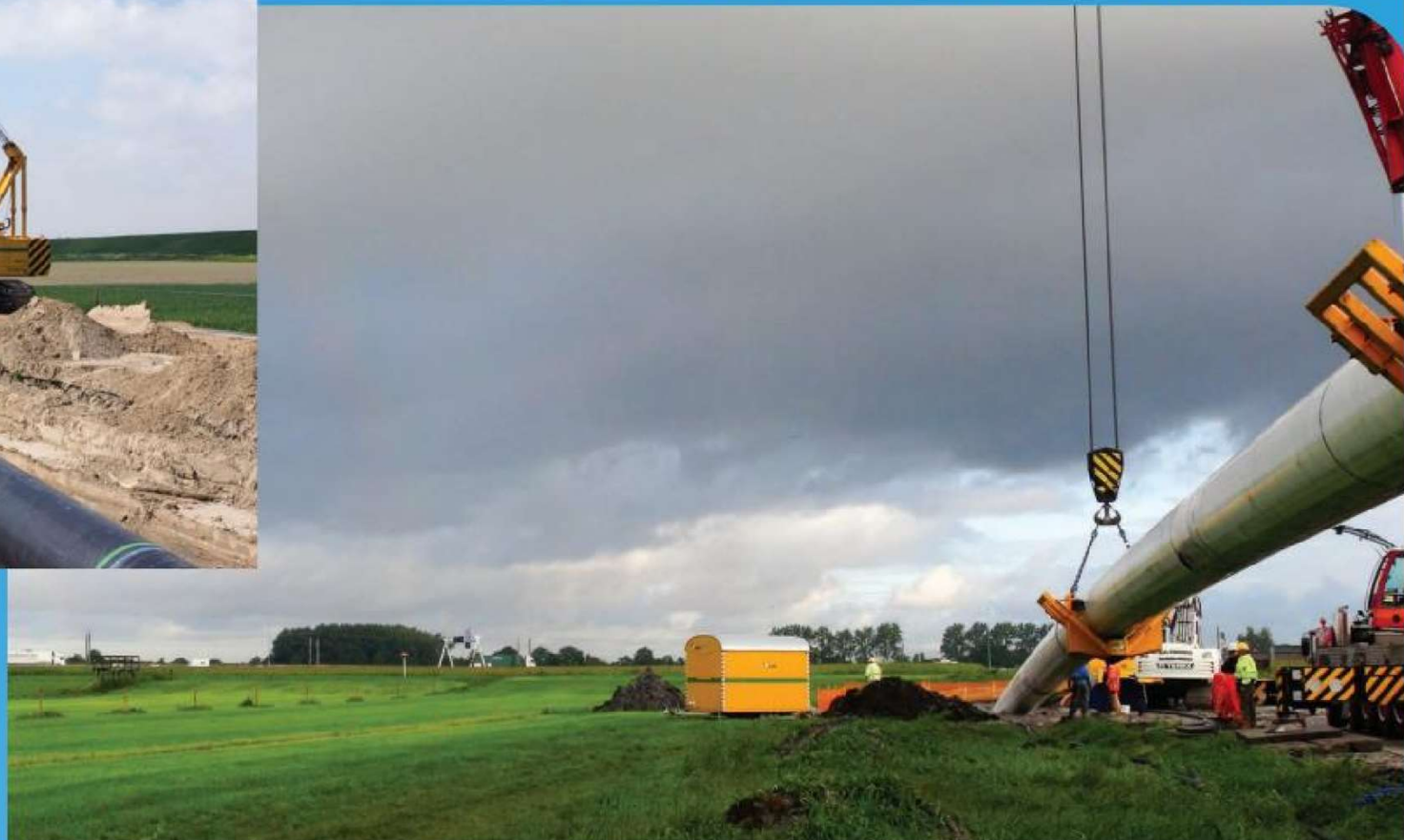
Aanleg leiding met horizontaal gestuurde boring
