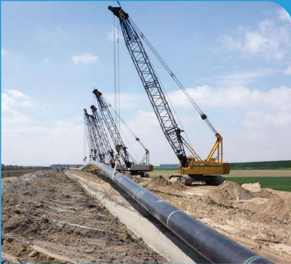
Aanleg leiding met open ontgraving
