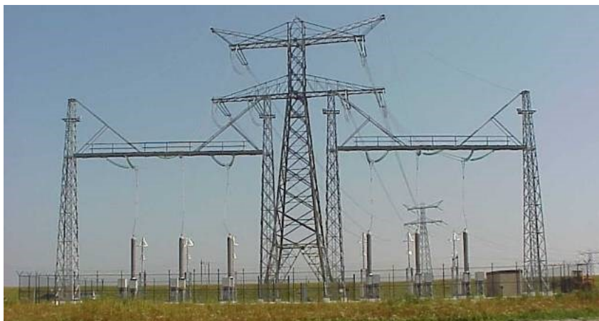
Figuur 10.7: Kabeleindsluiting (KES)
