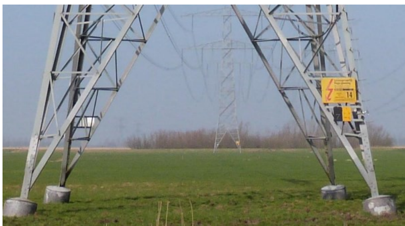
Figuur 10.4: Fundering van een vakwerkmast
