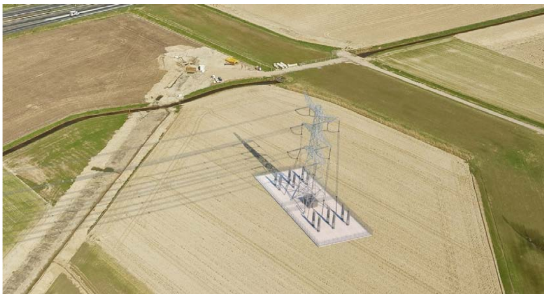
Figuur 10.3: Opstijgpunt 380kV-verbinding (foto van de verbinding Rilland-Tilburg).
