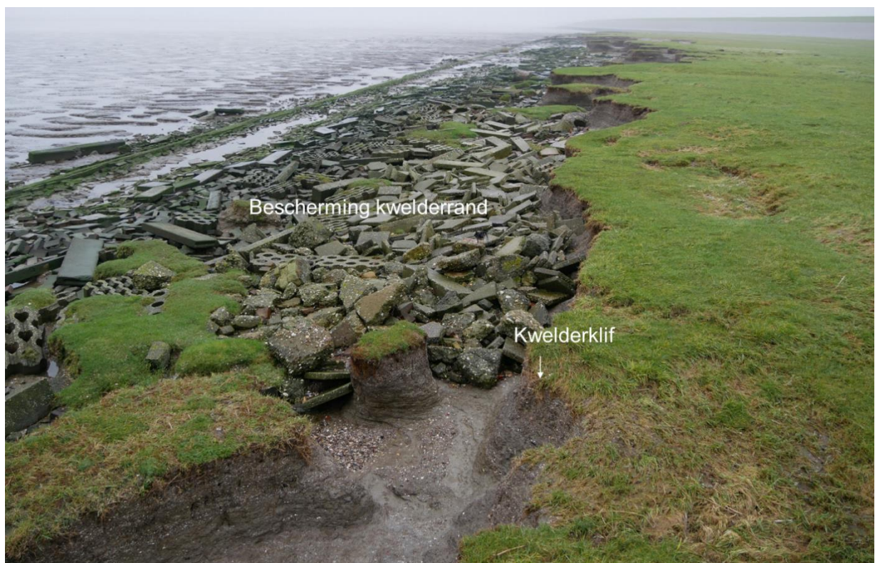
Figuur 11. Foto van de bestorte kwelderrand (opname 14 december 2021)
