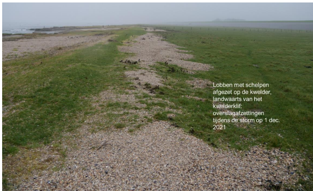
Figuur 12 Foto van de zomerkade met lobben van schelpen (overslagafzettingen) (opname 14 december 2021)
