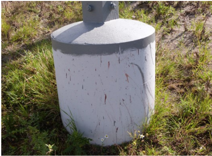
Afbeelding 4.2 Een voorbeeld van de verharding boven maaiveld van een mastvoet, bij een betonpaal fundering
