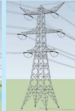
380kV hoekmast Moldau
