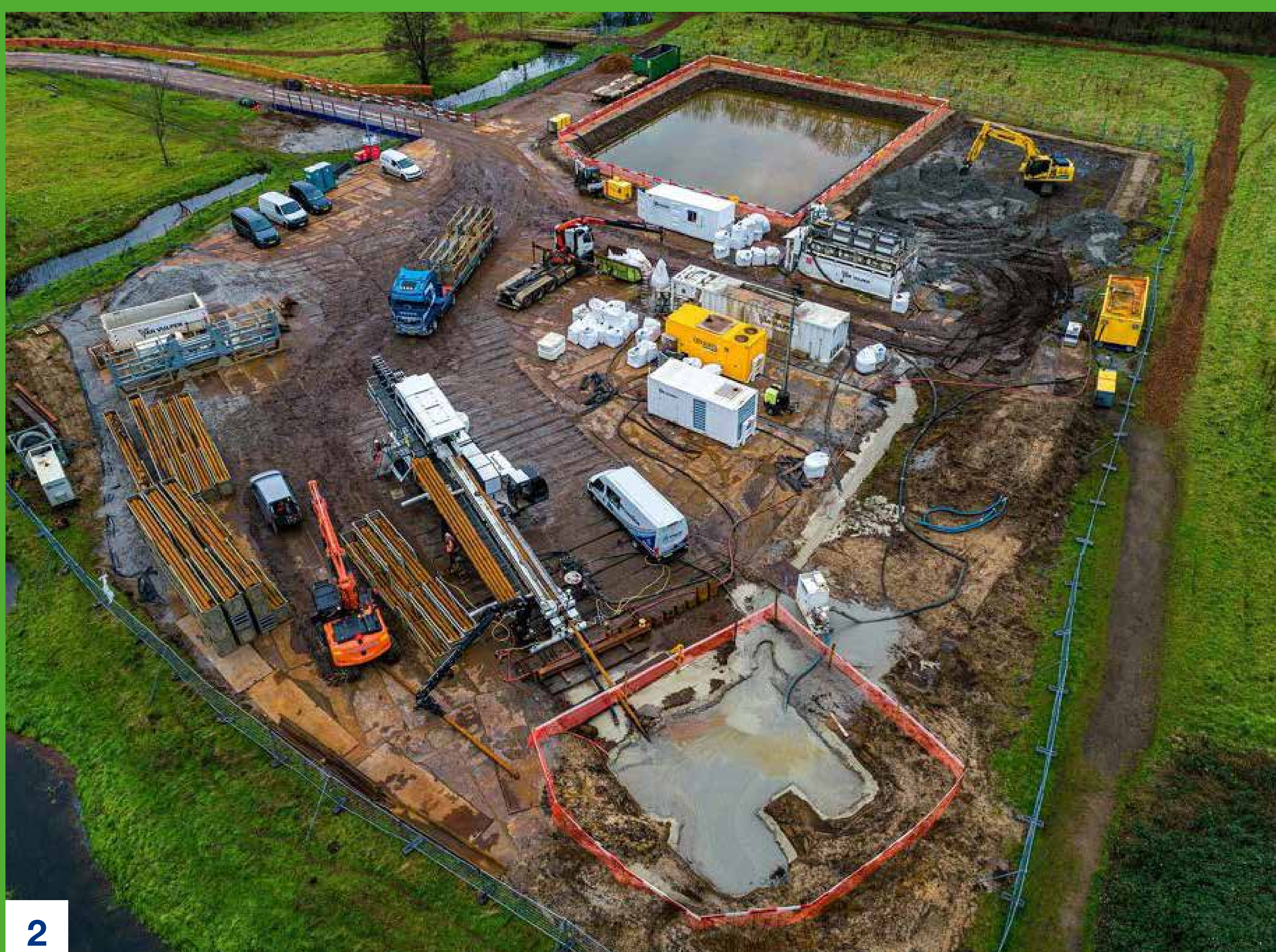
Principe kabelaanleg met horizontale boringen (HDD)
