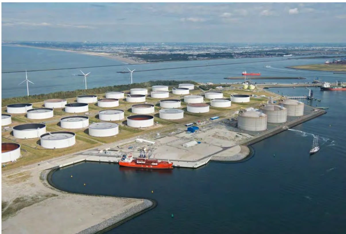
Figuur 6-6: Overzicht huidige situatie bij GATE en MOT terrein, met het Yangtzekanaal (rechts), de Yukonhaven en het huidige uitlaatpunt voor koelwaterlozing van GATE (de uitstroom is zichtbaar rechts bij de middelste tank).
