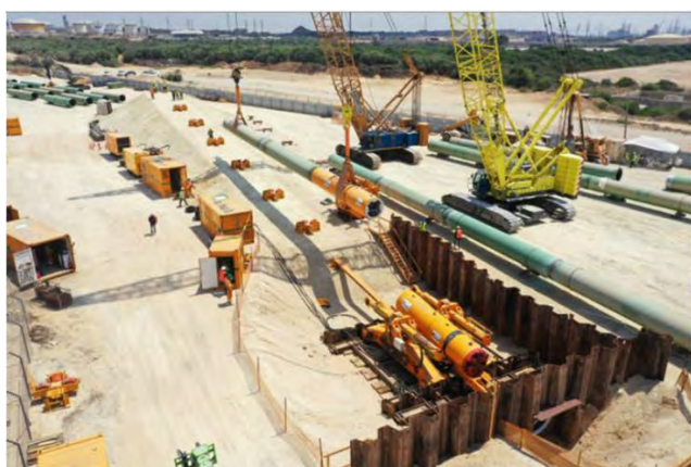
Figuur 8-17: Visuele indicatie aanleg bij direct pipe boortechniek.
