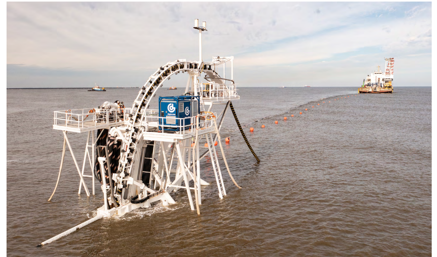
Figuur 9: Aanleggen van een 2 GW elektriciteitskabel op zee.
