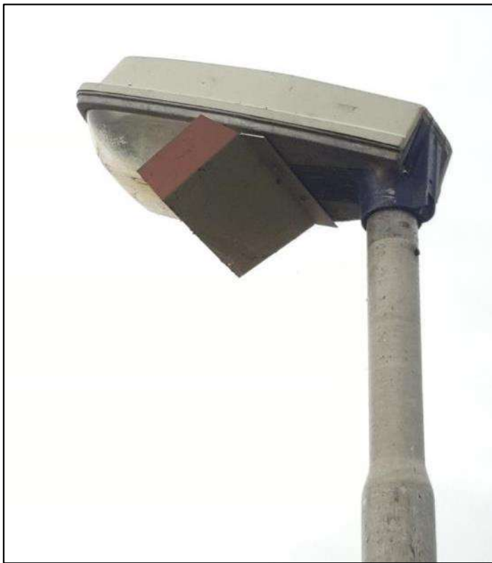
Figuur 4.1 Voorbeeld van een fysieke afscherming aan de achterzijde om lichtverstoring te voorkomen in een ander project. Bij de Julianavijver zal een soortgelijke oplossing wordt uitgewerkt en toegepast, waarbij de afscherming aan het armatuur of aan de mast bevestigd zal worden.
