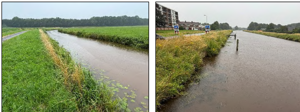
Figuur 2.3. Binnen het tracé bevinden zich brede watergangen het Drostendiep (links) en het Stieltjeskanaal (rechts) die mogelijk gebruikt kunnen worden als vliegroute door vleermuizen en geschikt foerageer en migratiegebied is voor de otter (zie ook paragraaf 2.3.4). Bron: Antea Group, 2024.
