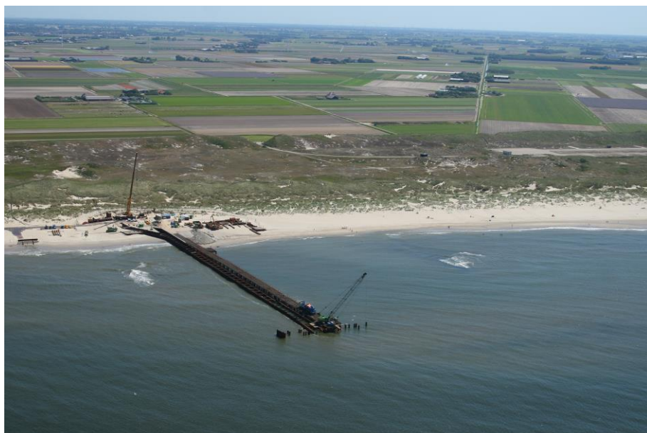
Afbeelding 7.17 Cofferdam nabij Julianadorp (Noord-Holland), gebruikt voor de aanleg van de BBL leiding in 2006
