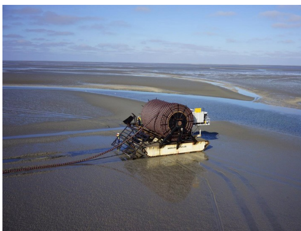
Figuur 4-7 Wadtrencher rol op rupsbanden over het wantij (Bron: TenneT)
