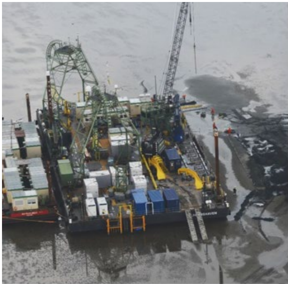
Werkzaamheden voor het ingraven en maken van een kabel mof
