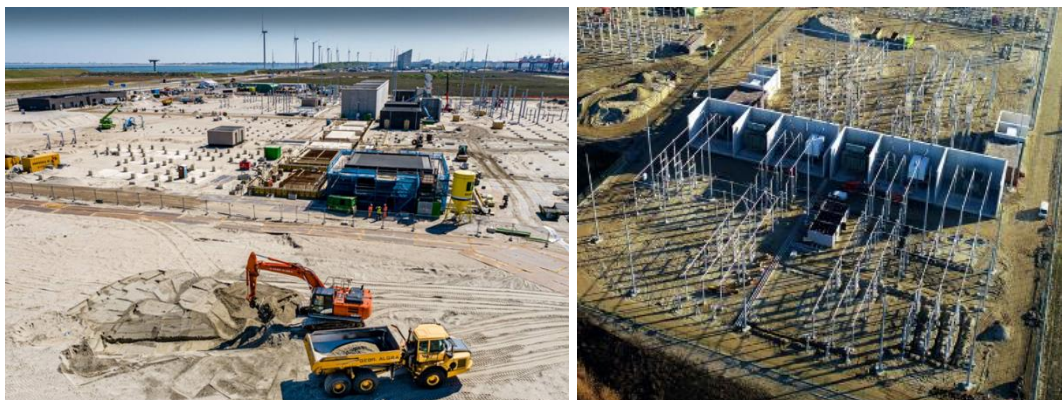
Afbeelding 34. Foto's van werkzaamheden aanleg transformatorstation
