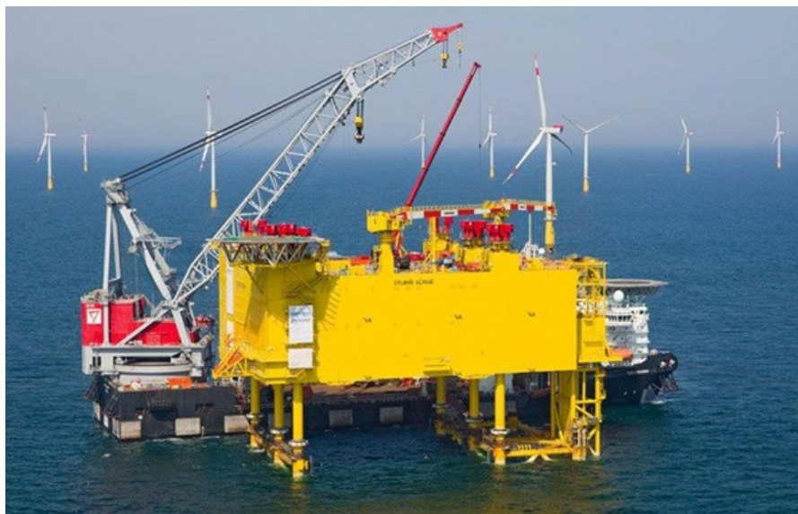
Figuur 4-17 Voorbeeld van een 2GW DC converterplatform (Bron: TenneT)
