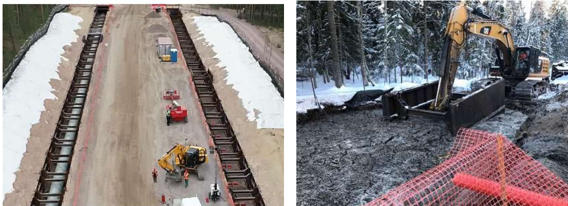
Figuur 2-19 Gebruik trenchboxen om hoeveelheid geroerde grond te beperken
