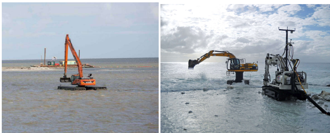
Figuur 2-20 Gebruik van amfibisch materieel ( waterkering.nl/ geocean.com )
