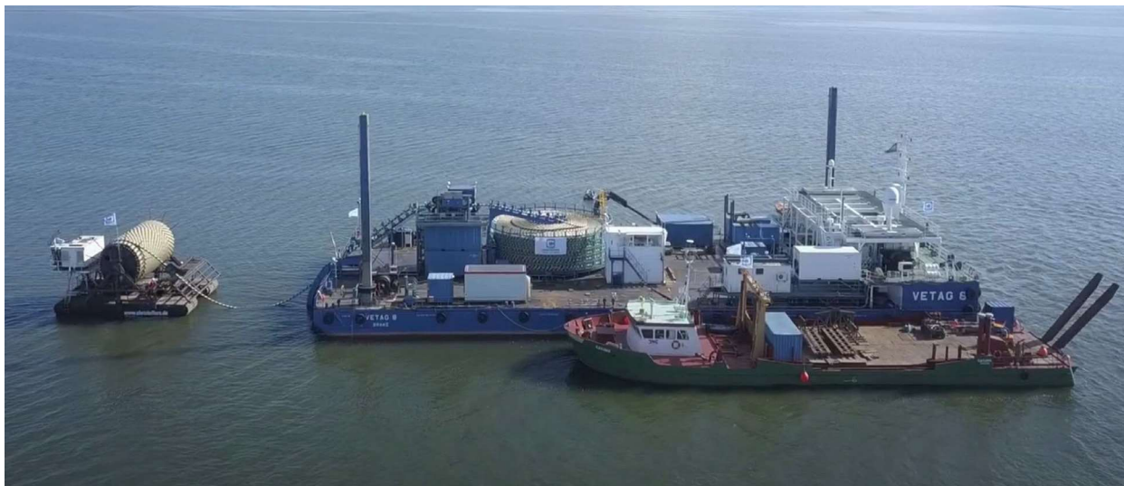
Figuur 4-6 Kabellegpontoon Vetag 8 en Wadtrencher rol (Bron: TenneT)
