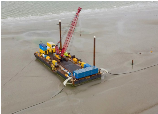
Figuur 4-9 Realisatie van een mofverbinding tussen twee kabelsegmenten (Bron: TenneT)
