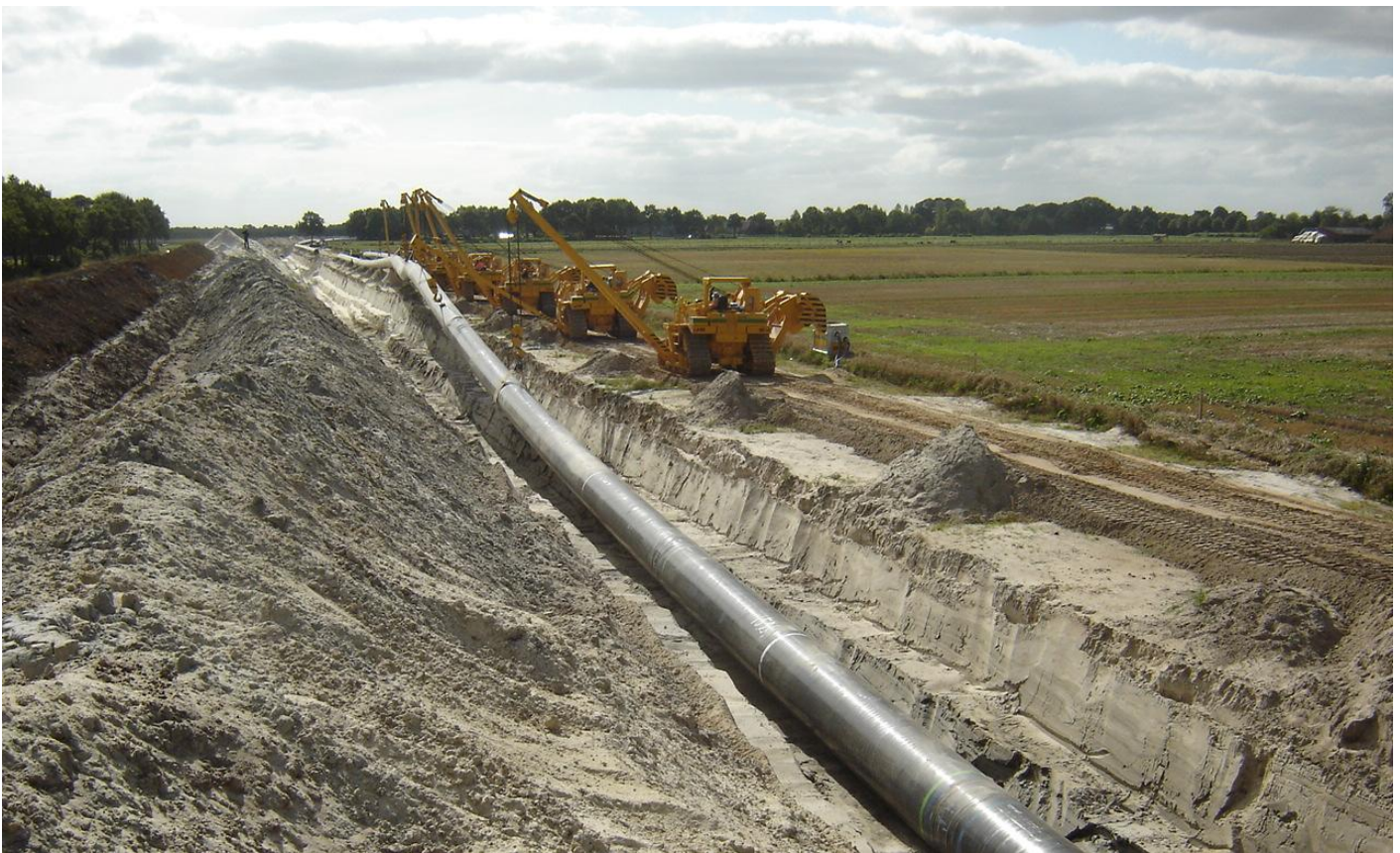
Figuur 3-6 Aanleg van buisleidingen in open ontgraving
