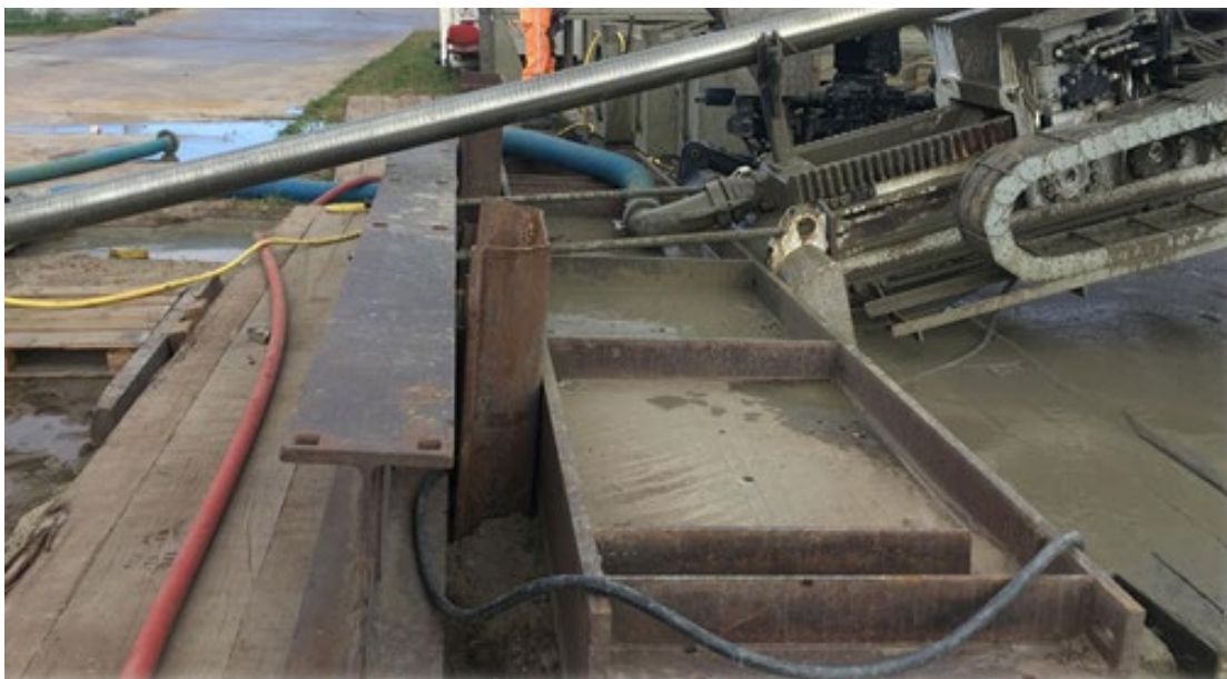
Afbeelding 16 Een voorbeeld van de verankering van boormachine aan de damwanden
