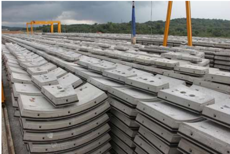
Figuur 2-12 Opslag tunnelsegmenten
