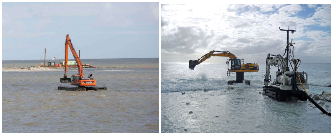
Figuur 2-20 Gebruik van amfibisch materieel ( waterkering.nl/ geocean.com )
