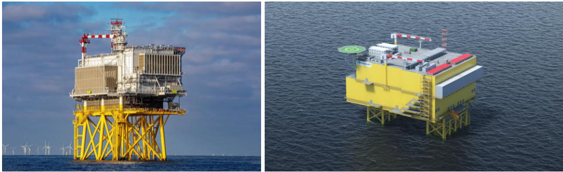
Abbildung. 3.2 Die Offshore-Plattform (links DC, rechts AC)
