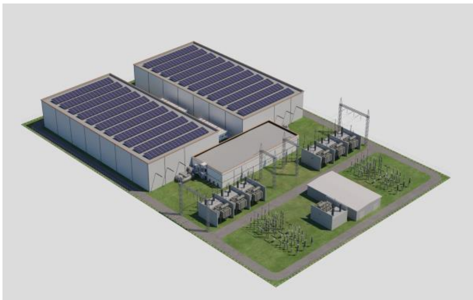
Afbeelding 35. Indicatieve weergave van een converterstation (2 GW)
