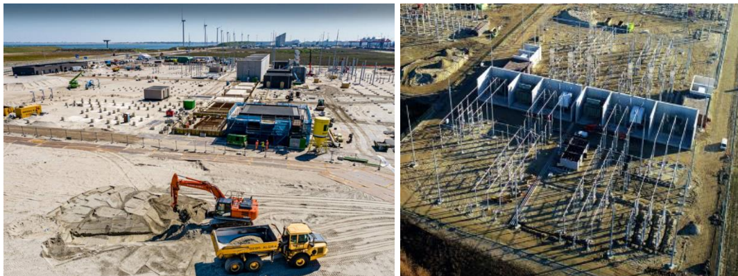
Afbeelding 34. Foto's van werkzaamheden aanleg transformatorstation
