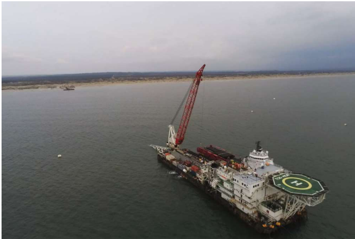
Figuur 2-14 Allseas Tog Mor bij Houstrup Denemarken aanlanding Europeipe II branch line, intrekken pijpleiding
