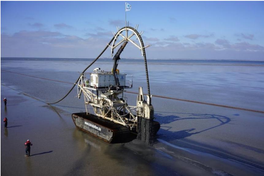
*Ein Beispiel für eine Watt-Grabenfräse – In Zusammenarbeit mit dem NIOZ und Wageningen Marine Research wurde untersucht, wie diese Watt-Grabenfräse eingesetzt werden kann, um die Auswirkungen auf Natur und Ökologie zu minimieren.*
