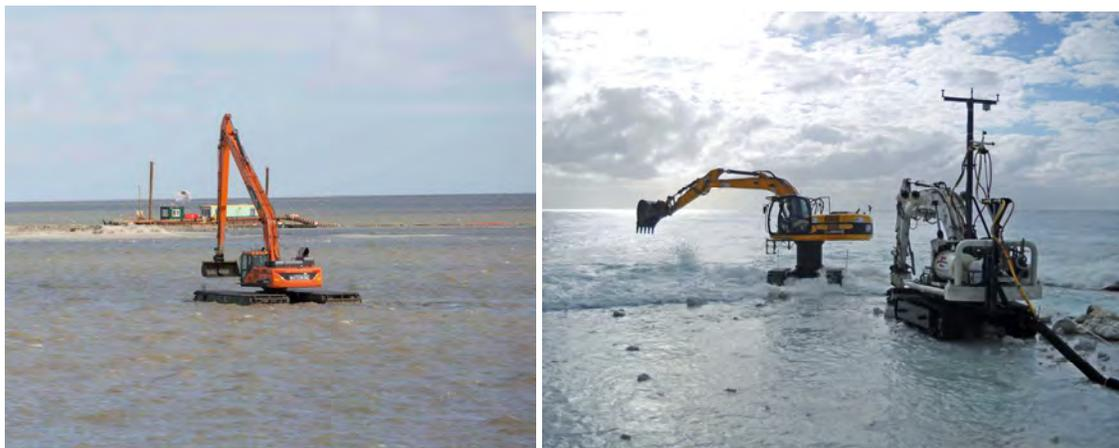
*Figuur 2-20 Gebruik van amfibisch materieel ([waterkering.nl/](http://waterkering.nl/) [geocean.com](http://geocean.com))*
