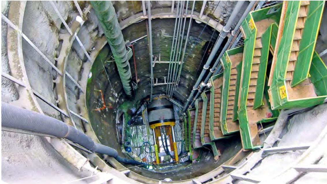
Figuur 2-13 Toegangsschacht voor een Herrenknecht AVN D2400AH (3 m kabeltunnel, <https://www.herrenknecht.com/en/references/referencesdetail/seoul-cable-tunnel/>)
