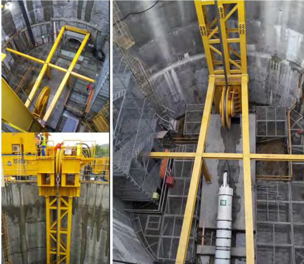
*Figuur 2-16 Schacht met katrol en ingetrokken pijpleiding*
