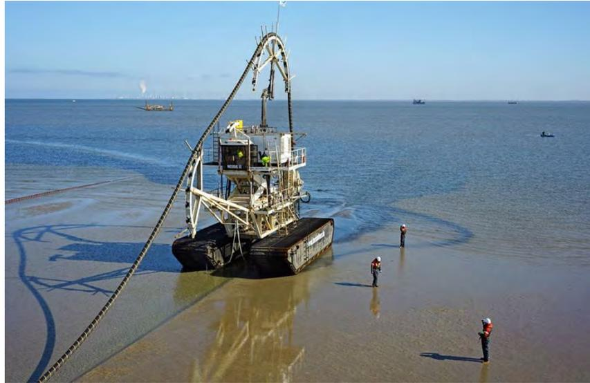
Afbeelding 21. Kabel installatie door de Nessie II
