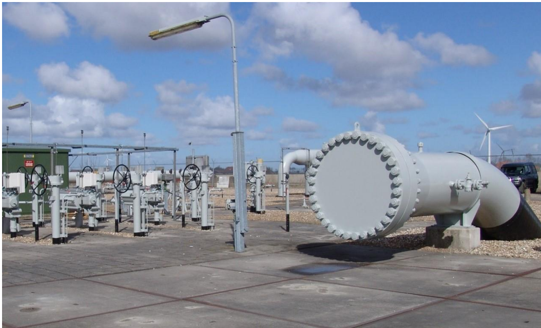
Figuur 5: Scraper trap (rechts op de foto) – faciliteit voor een pigrun
