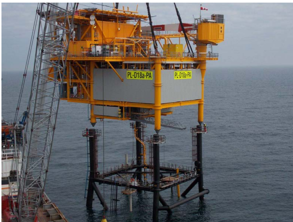
Figuur 2-10: Afbeelding van de plaatsing van een platform op een onderbouw (ter illustratie).
