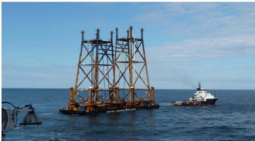
Figuur 2-12: Transport van de onderbouw (samen met een 2 e jacket voor een andere locatie).
