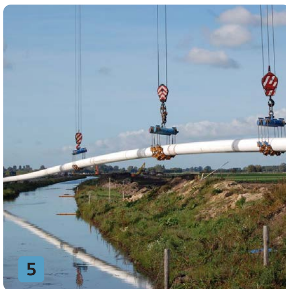
Aanleg op het land Horizontaal gestuurde boring (HDD)
