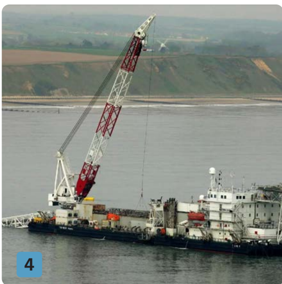
Aanleg op de zee Aanlegsschip (bron: Allseas)
