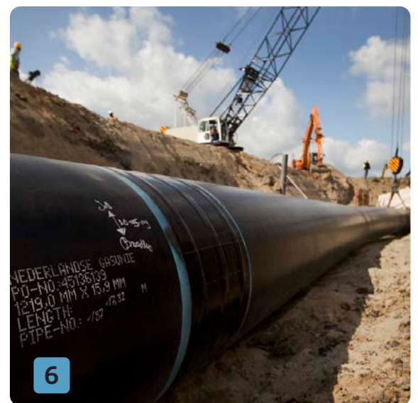
Aanleg op het land Open ontgraving
