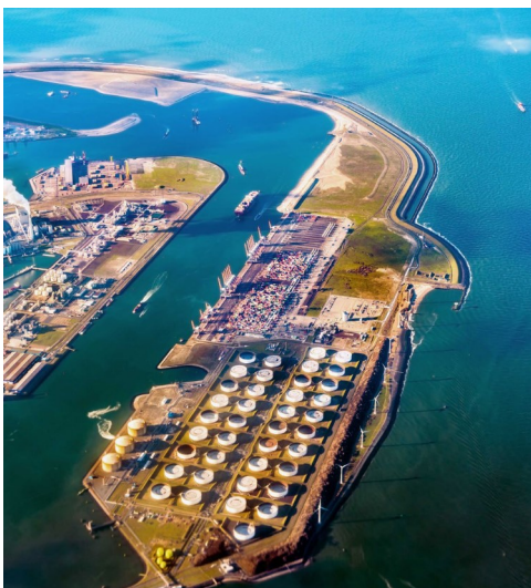
Figuur 2.11 Luchtfoto van de huidige situatie met het Yangtzekanaal links en de Maasmond rechts
