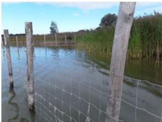
Afbeelding 4.7 Schapengaas met uitgroeizone van riet [ref. 2]
