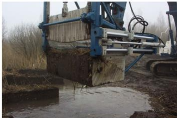
Afbeelding 4.5 Beeldimpressie werkwijze afplaggen en plaatsen rietplaggen (Bron; Scirpus Ecologisch Advies; Evaluatierapport Winning en aanplant van rietplaggen in Ondiepe Zones Ketelmeer en Zwarte Meer)
