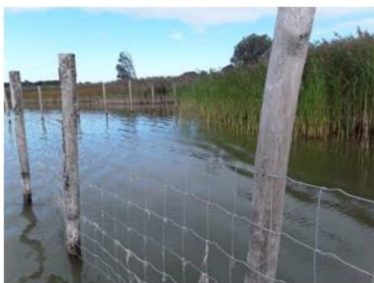
Afbeelding 3.7 Schapengaas met uitgroeizone van riet [ref. 2]
