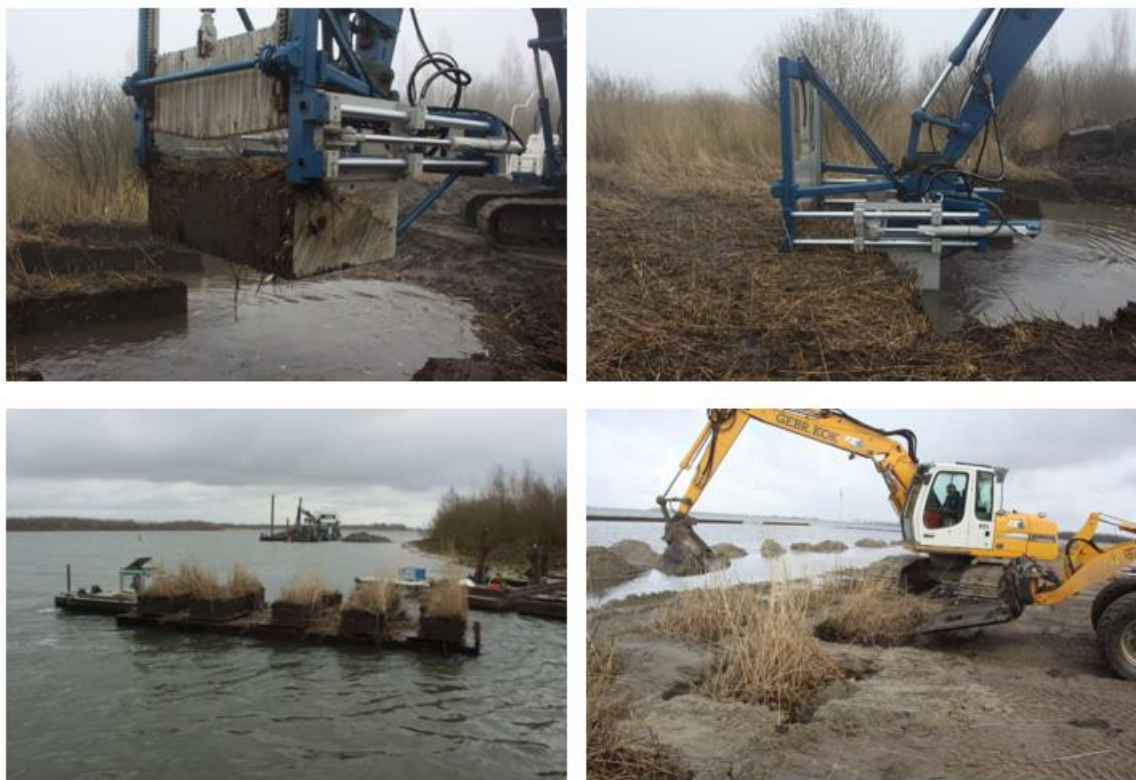
Afbeelding 3.5 Beeldimpressie werkwijze afplaggen en plaatsen rietplaggen (Bron; Scirpus Ecologisch Advies; Evaluatierapport Wining en aanplant van rietplaggen in Ondiepe Zones Ketelmeer en Zwarte Meer)
