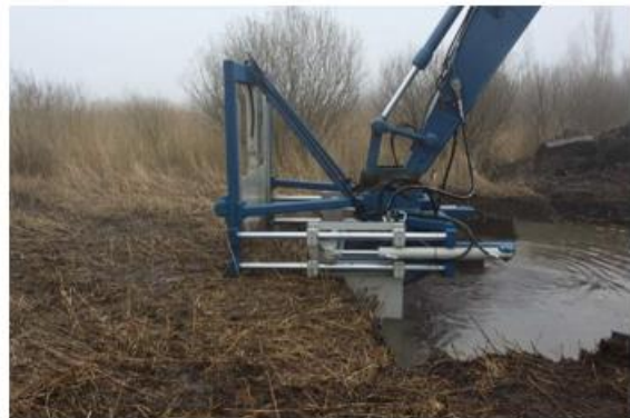
Afbeelding 4.5 Beeldimpressie werkwijze afplaggen en plaatsen rietplaggen (Bron; Scirpus Ecologisch Advies; Evaluatierapport Winning en aanplant van rietplaggen in Ondiepe Zones Ketelmeer en Zwarte Meer)
