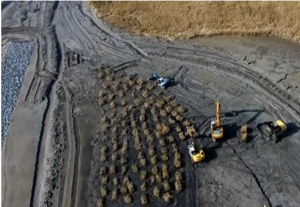
Afbeelding 4.4 Voorbeeld aanbrengen Rietplaggen in project RvR IJsseldelta (print screen uit film met dronebeelden)
