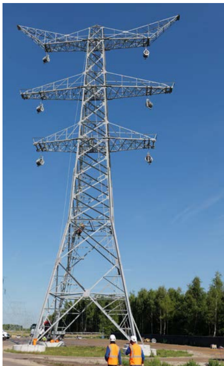
Afbeelding 2: de eerste Moldaumast bij het nieuwe hoogspanningsstation in Tilburg.
