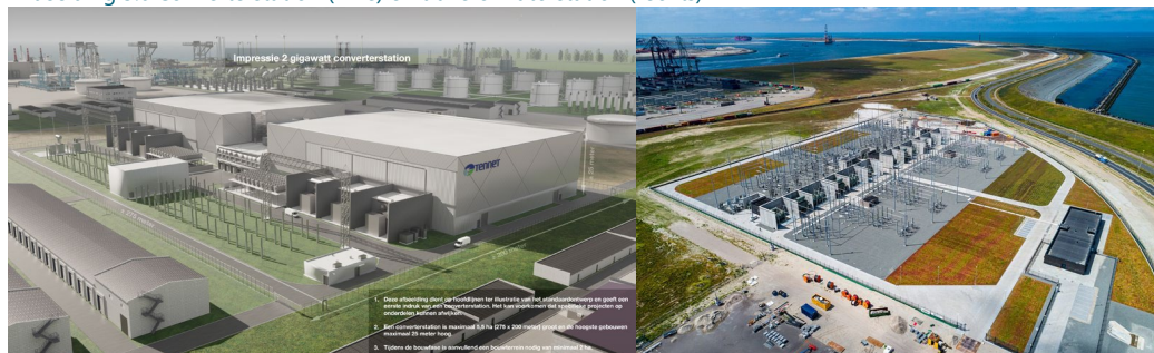
Afbeelding 3.6 Converterstation (links) en transformatorstation (rechts)
